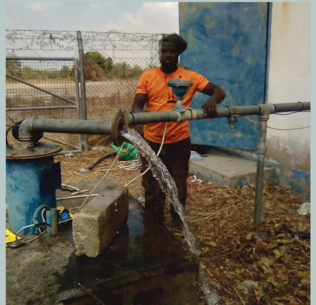
Sanierungsarbeiten für sauberes Trinkwasser in Busunu
